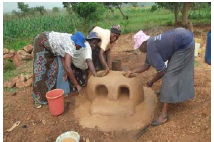
289 dieser brennholzsparenden Lehmöfen wurden errichtet. Sie sparen Zeit und sind gut für die Umwelt.
